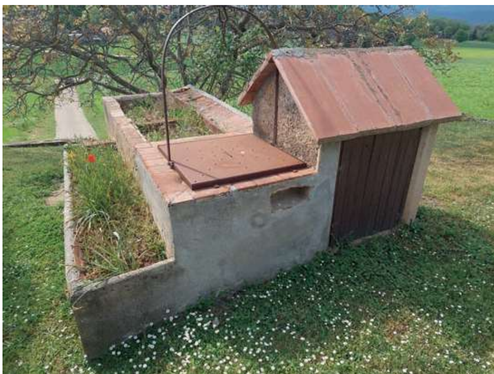
Abeurador i safareig en una de les cisternes del Mas Pujalós
