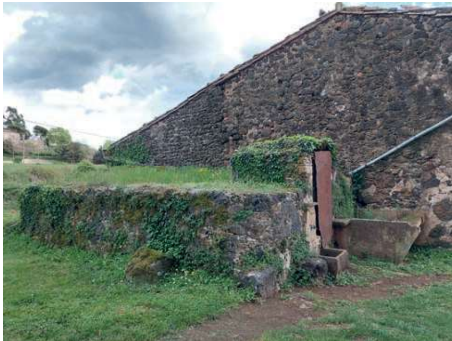
La cisterna del mas El Ripoll que recull l'aigua de la cabanya
